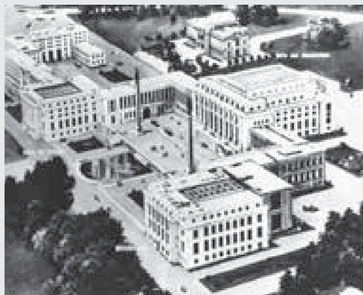
Undatierte Luftaufnahme vom Gesamtkomplex des Völkerbundpalais in Genf / Schweiz, der zwischen 1929 und 1936 erbaut worden ist. Foto: picture-alliance / dpa
